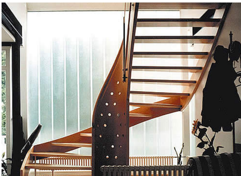
Kuva 33. Lasilankuista rekannettu seinä 49 .
