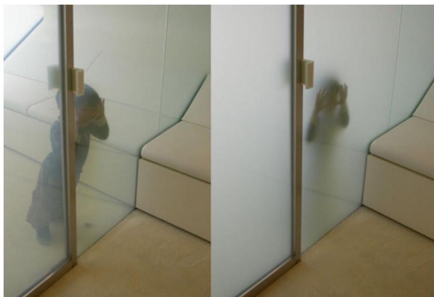
Kuva 29. Sähkökromaattinen lasi 45 .
