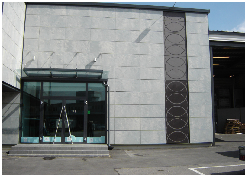
Kuva 55. Hiekkapuhalluttu kuviointi keramiikkalaattaan (Laattapiste, Vantaa), suunnittelu: Hanna Korvela, 2004.
