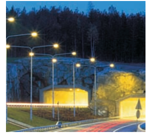
Kuva 6. Tunneli on osa liikenneväylää.
